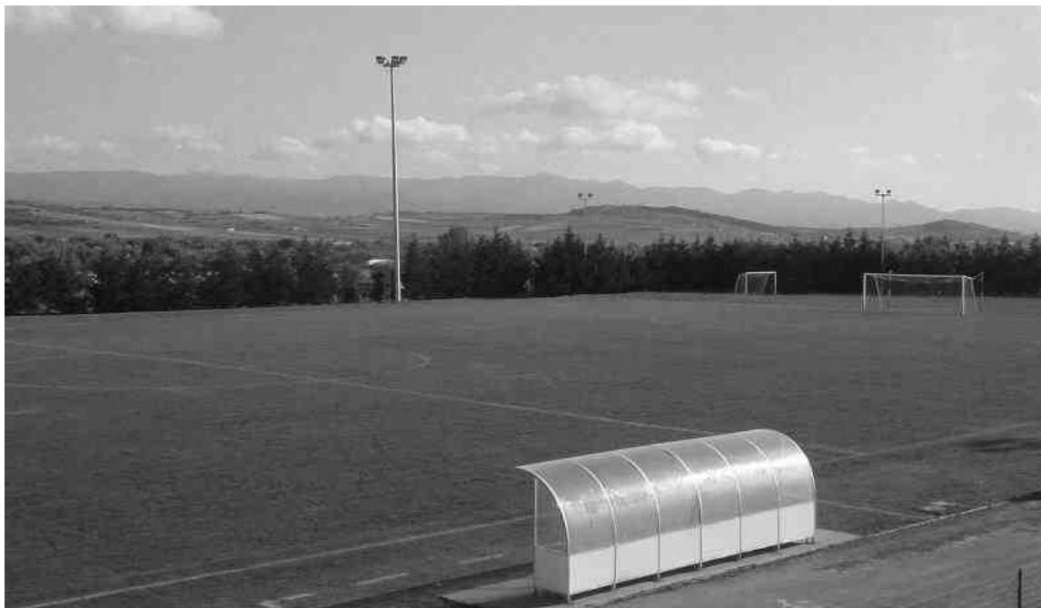
Il nuovo campo di Sant'Elena dopo i lavori
